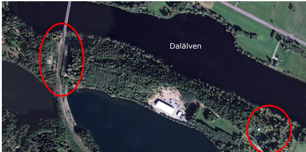
Figur 4 Lennheden vattenverk (vit byggnad i mitten av bilden) och brunnsområde strax norr om byggnaden. Cirklarna visar på närmast belägna hushåll 300-450 m från uttagsområdet.
